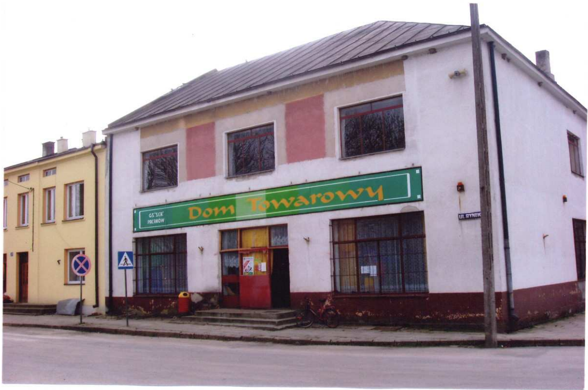
Nr 1. Widok elewacji północnej Domu Towarowego.
