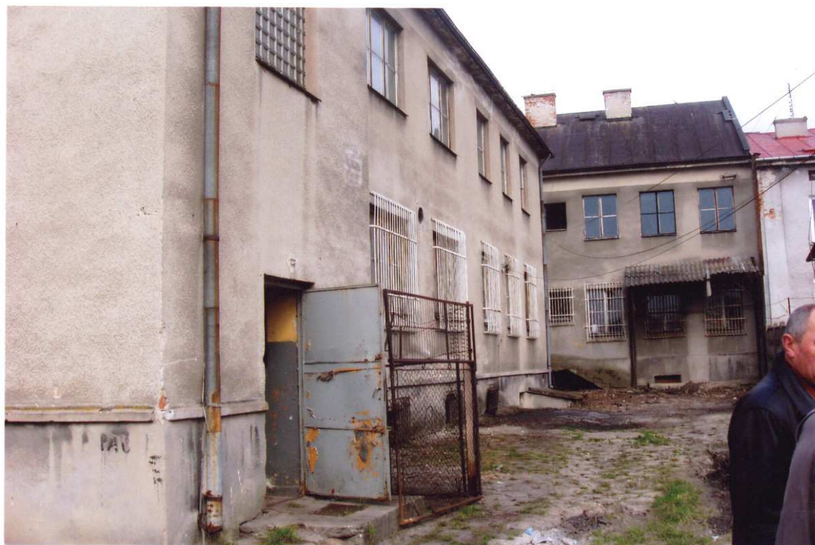
Nr 6. Widok elewacji południowej budynku "R" / w głębi/ oraz elewacji wschodniej budynku "N".
