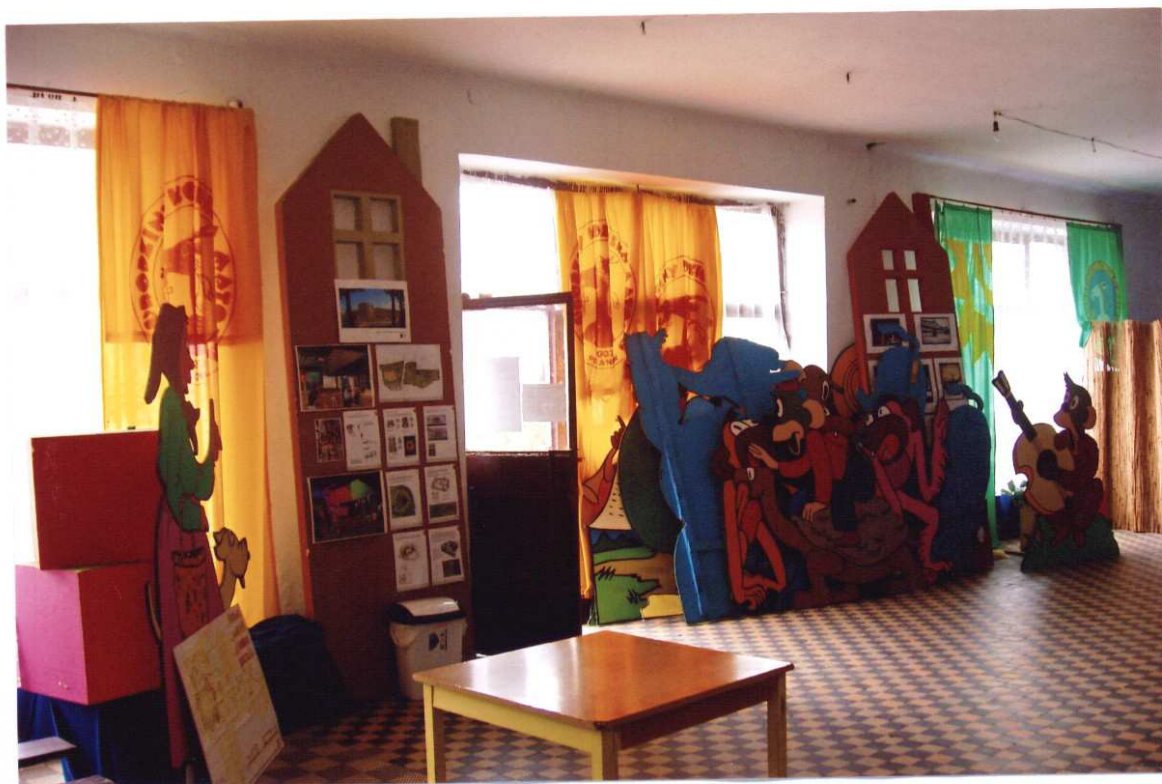
Nr 11. Widok tynków i posadzki w sali wystawowej budynku "R".
