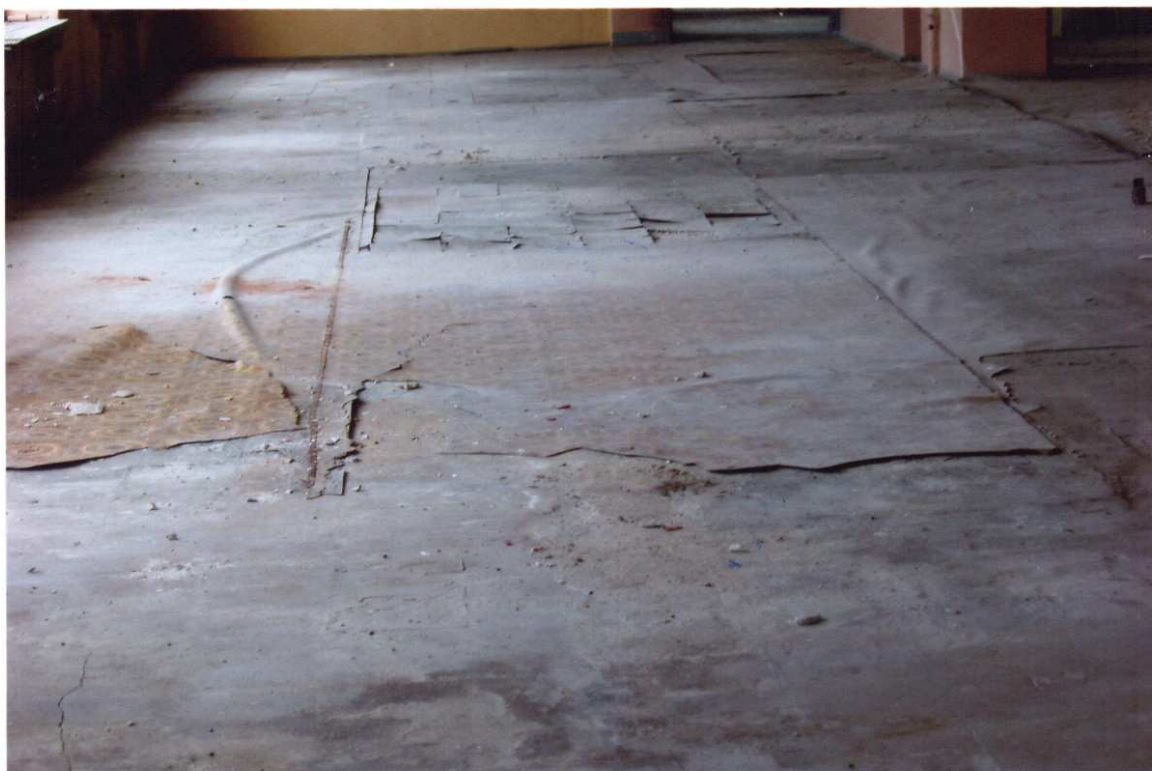
Nr 22. Widok zniszczonej posadzki z płytek PCV w sklepie na budynku "N".
