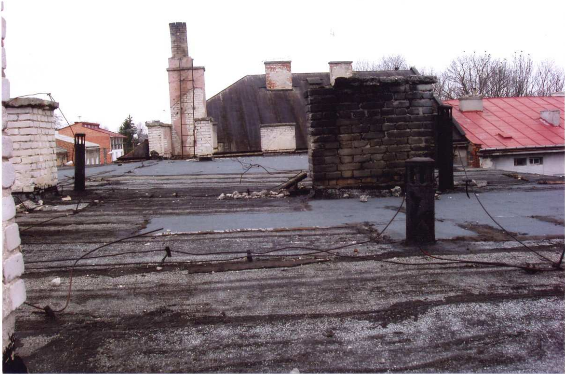
Nr 9. Widok pokrycia stropodachu budynku "N" oraz kominów i odpowietrzenie pionów kanalizacyjnych.
