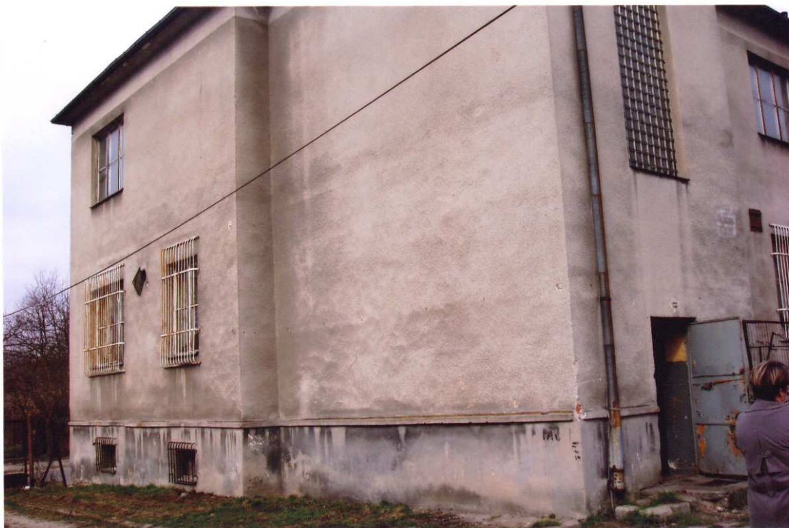
Nr 7. Widok elewacji południowej budynku "N".
