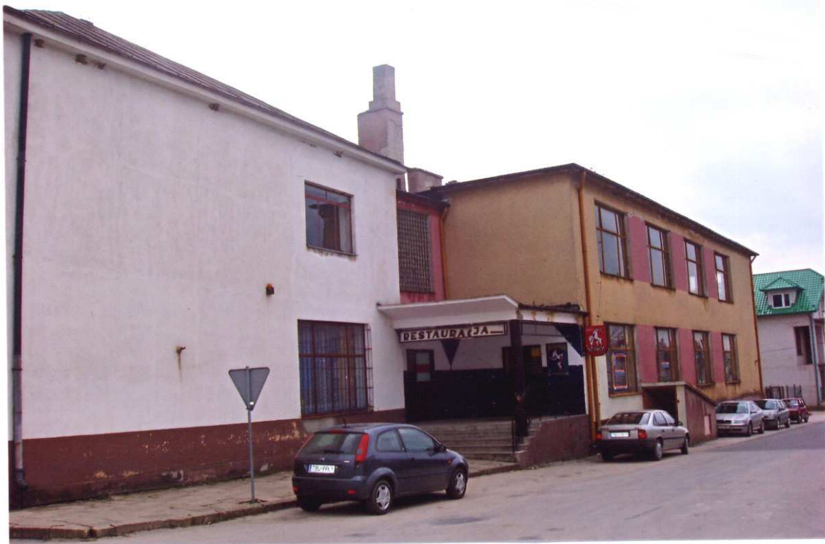
Nr 2. Widok elewacji zachodniej budynku " N" /budynku restauracyjnego/ i budynku " R" /handlowego/.
