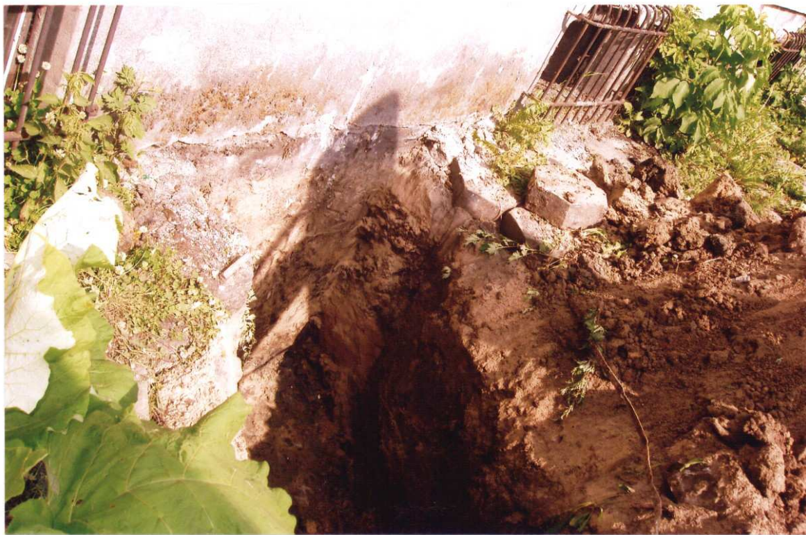
Nr 30. Widok odkrywki ściany piwnicznej od strony wschodniej budynku "N".
