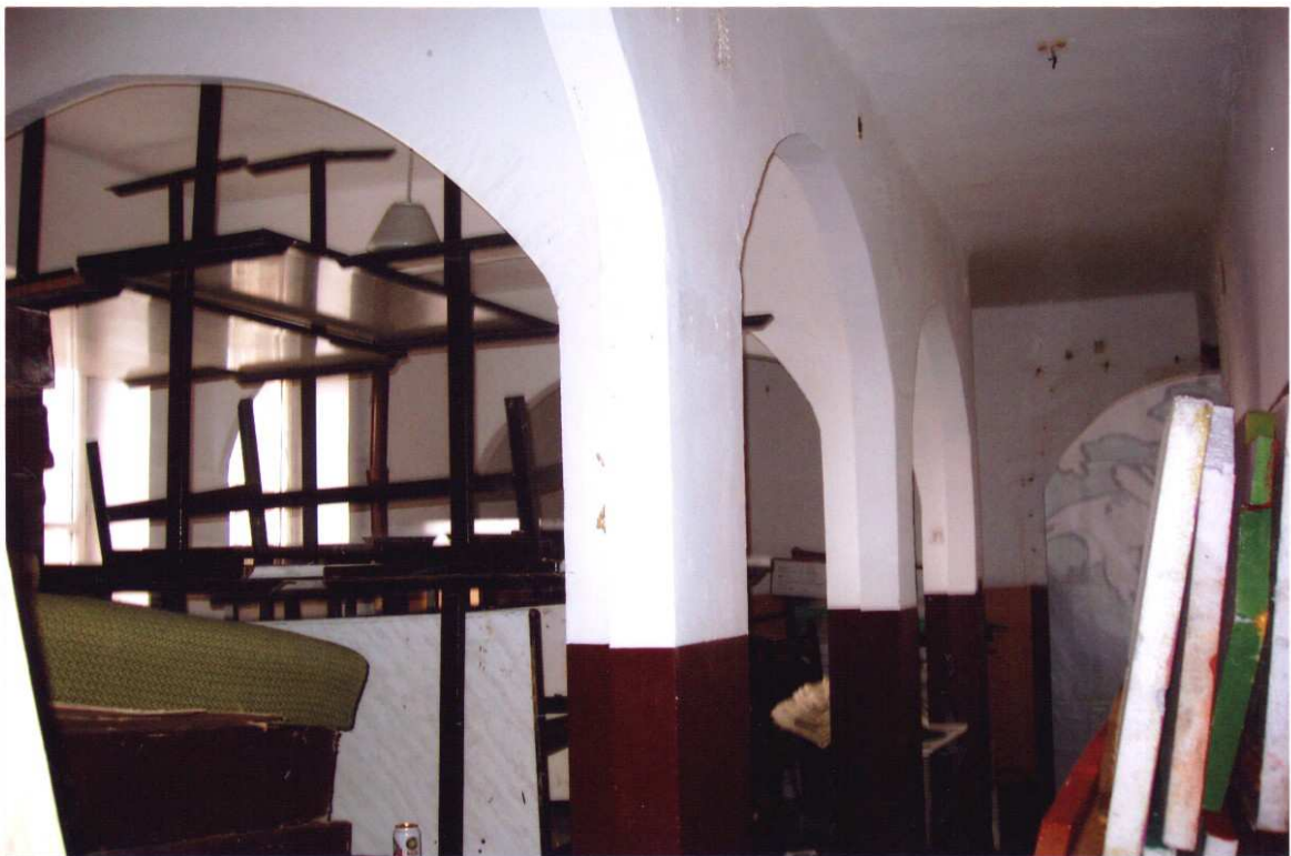
Nr 14. Widok pomieszczenia zaplecza dla sali widowiskowej w parterze budynku "R".
