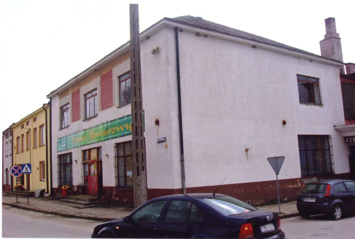
Nr 3. Widok elewacji północnej i zachodniej budynku "R".
